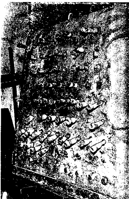
Bild 154. Stark abgezehrte und gelockerte Stehbolzen
