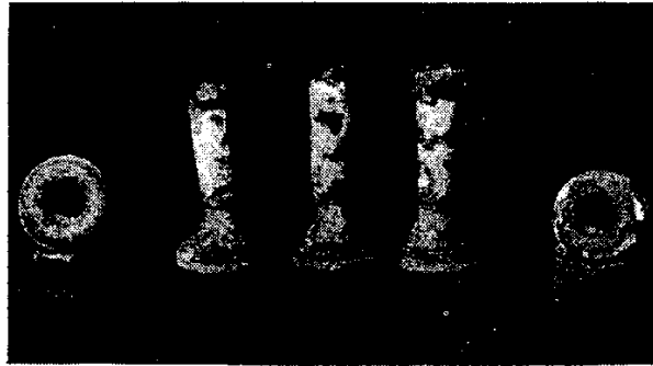
Bild 155. Stark abgezehrte Stahlstehbolzen
